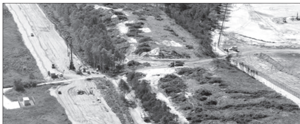
Część placu budowy
